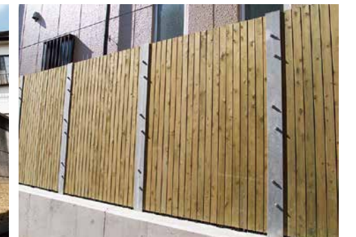
学校の万年塀の建て替え事業。東京都推奨仕様で、鋼製フレームとのドッキング。 (施主：日本大学豊山女子高等学校・中学校様 / 施工：株式会社原設備工業様)
