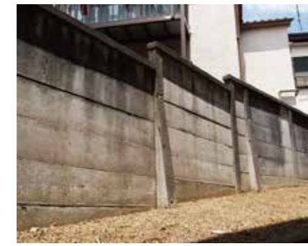
学校の万年塀の建て替え事業。東京都推奨仕様で、鋼製フレームとのドッキング。 (施主：日本大学豊山女子高等学校・中学校様 / 施工：株式会社原設備工業様)
