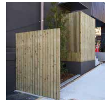
手前) 42x85角 平並べ 目隠し H1800 コンクリート土間に埋め込み (工事中写真) 後ろ) 30x60角 格子とのコンビ H1800
