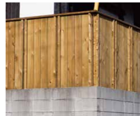
42x85角と30x120板の目隠しフェンス H1200 既設の土留めブロックの上にストレートピン工法で設置
