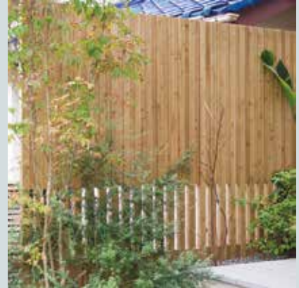
コンクリート基礎に立てる
