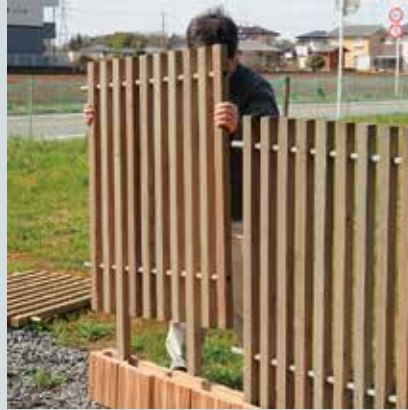
コンクリートブロックに差し込む
