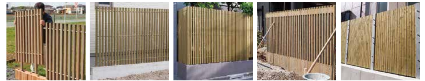
コンクリートブロック上に 布基礎（新設）上に 布基礎（既設）上に 地面に溝掘り そのほかにも
