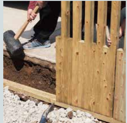
溝に並べ立て、コンクリートを流す
