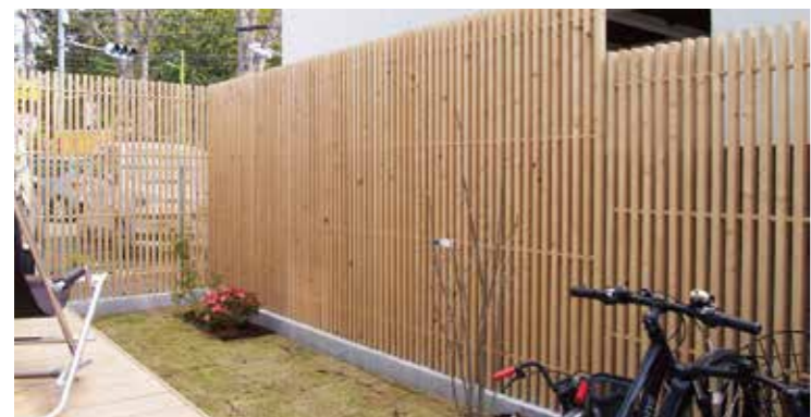
30x60角 格子 H2000 型枠ブロックの基礎に施工 無色透明の防腐剤を使用
