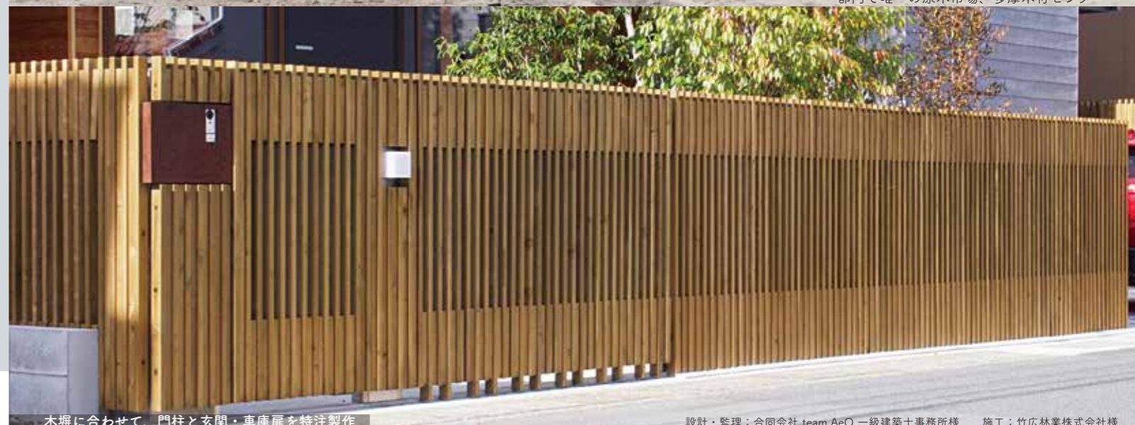
木塀に合わせて、門柱と玄関・車庫扉を特注製作
