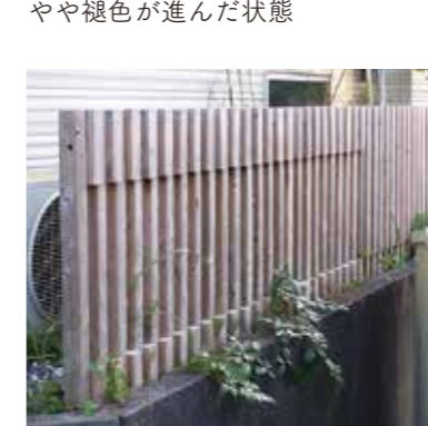
旧仕様) 56角 目隠し 風穴あり H800 穴掘り施工 丸穴を偏心させて凹凸のデザインすでに褪色して灰色に
