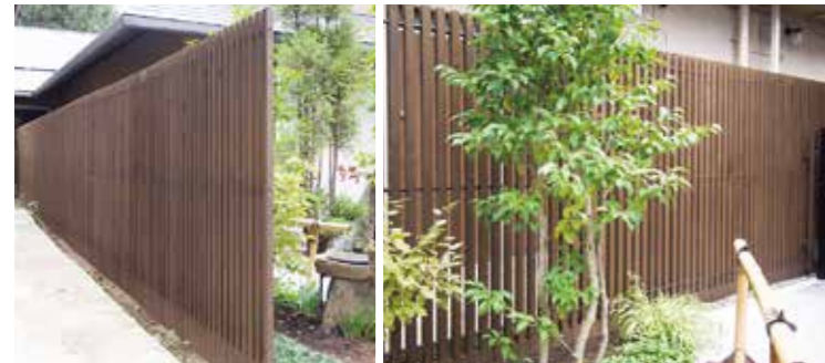
42角 格子 H1800 隣地境界際に溝掘り施工、施工前に塗装
