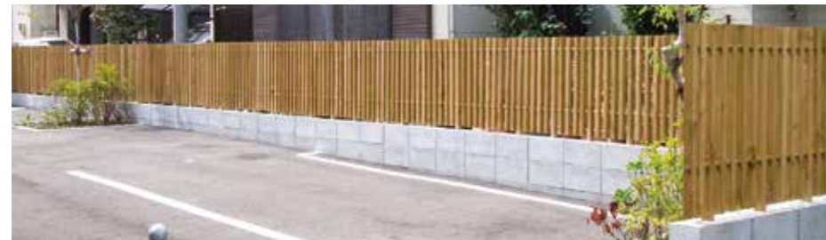
42角 格子 H800 新設のコンクリートブロックに施工
