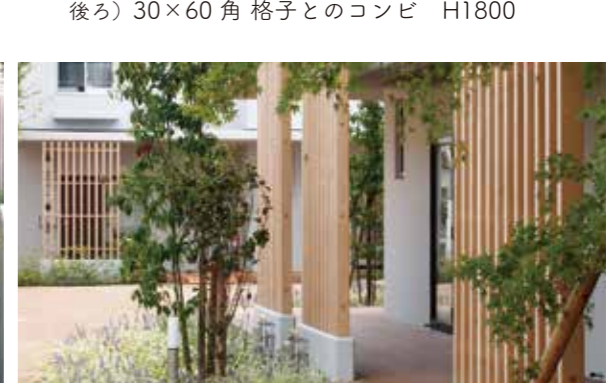
特注) 45x100角 格子 H2400 コンクリート基礎と底の間に、けんどん式ではめ込み 無色透明の防腐剤を使用
