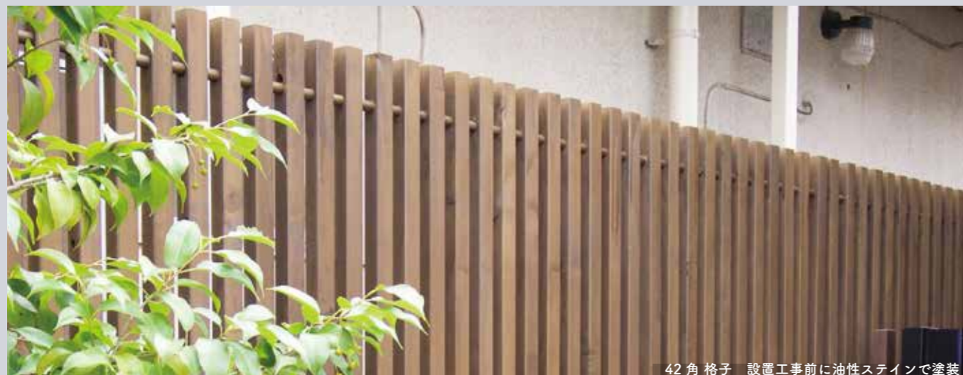
42角 格子 設置工事前に油性ステインで塗装
