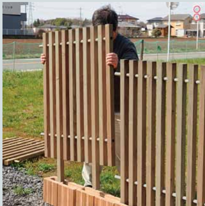
コンクリートブロックに差し込む
