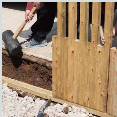
溝に並べ立て、コンクリートを流す
